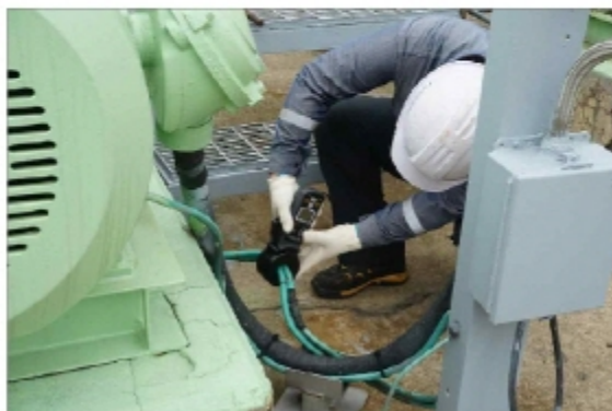
[펌프 접지저항 측정]
