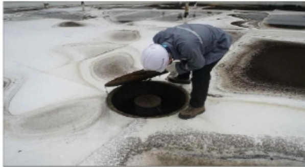
[부상 지붕 빗물 집수조 점검]
