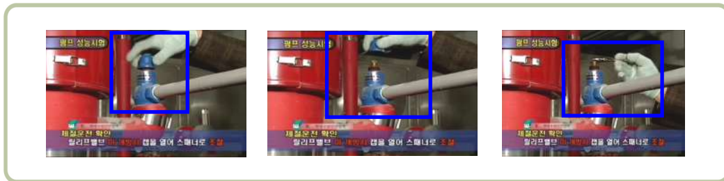
[그림 VIII-16] 릴리프밸브 캡을 열어 스페너로 조절하는 모습
