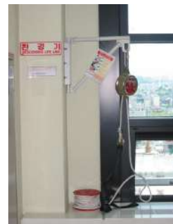
[그림 V-24] 완강기 설치 모습
