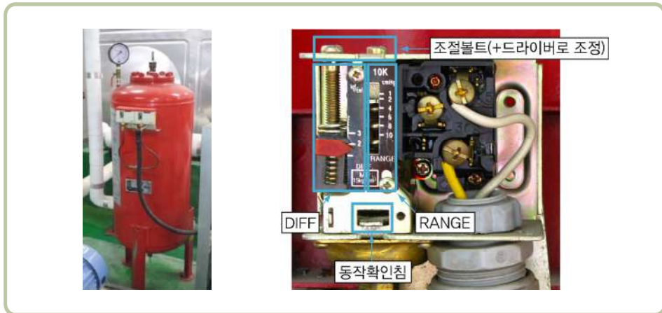
[그림 VIII-21] 기동용수압개폐장치(압력챔버)와 압력스위치
