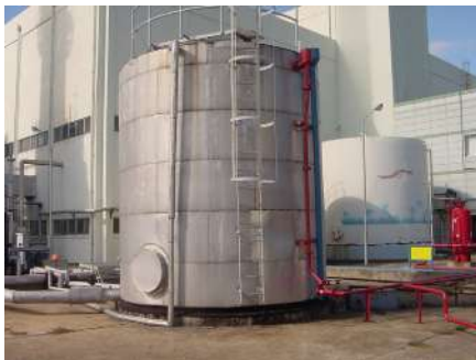
[그림 V-8] 포소화설비 설치모습
