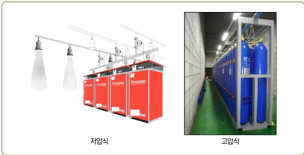
[그림 V-10] 저·고압식이산화탄소소화설비 저장용기 비교
