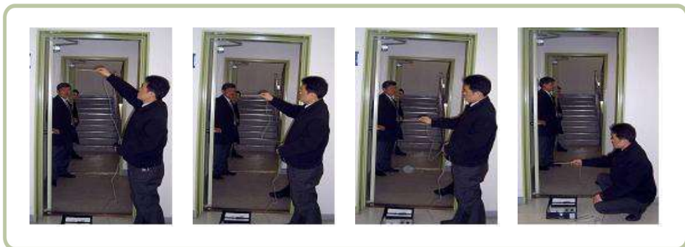
[그림 V-49] 계단실·부속실 방연풍속 측정
