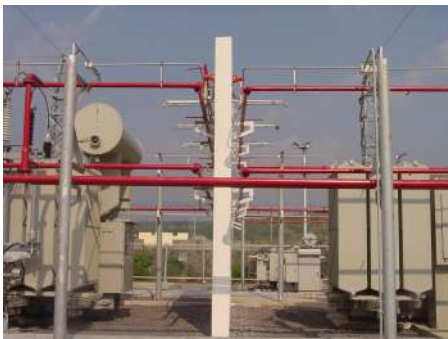
[그림 V-6] 물분무소화설비 설치모습
