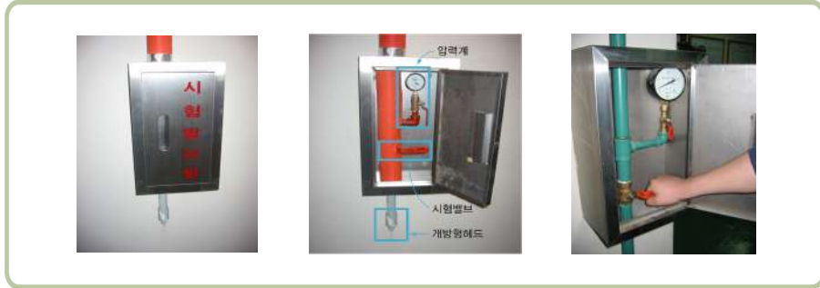
[그림 Ⅷ-22] 말단시험밸브 및 시험밸브 개방
