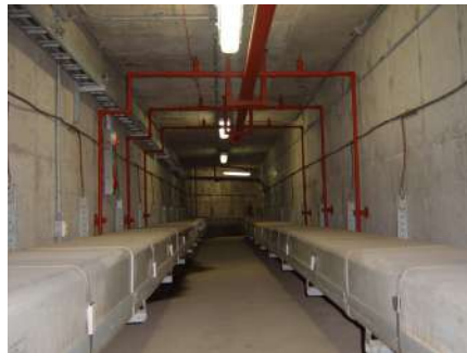
[그림 V-52] 연소방지설비 설치 예
