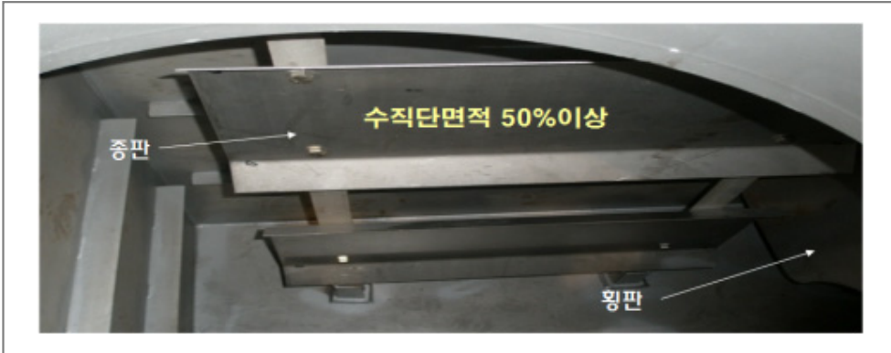
[그림 3-58] 물탱크 내부 방파판
