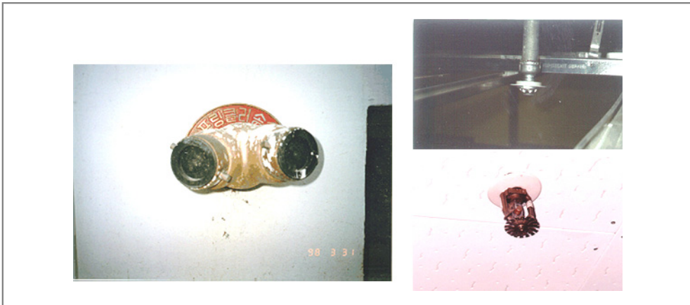
[그림 1-88] 스프링클러 송수관 및 헤드의 설치 예
