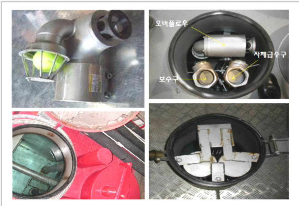
[그림 3-59] 물탱크 상부 맨홀내부
