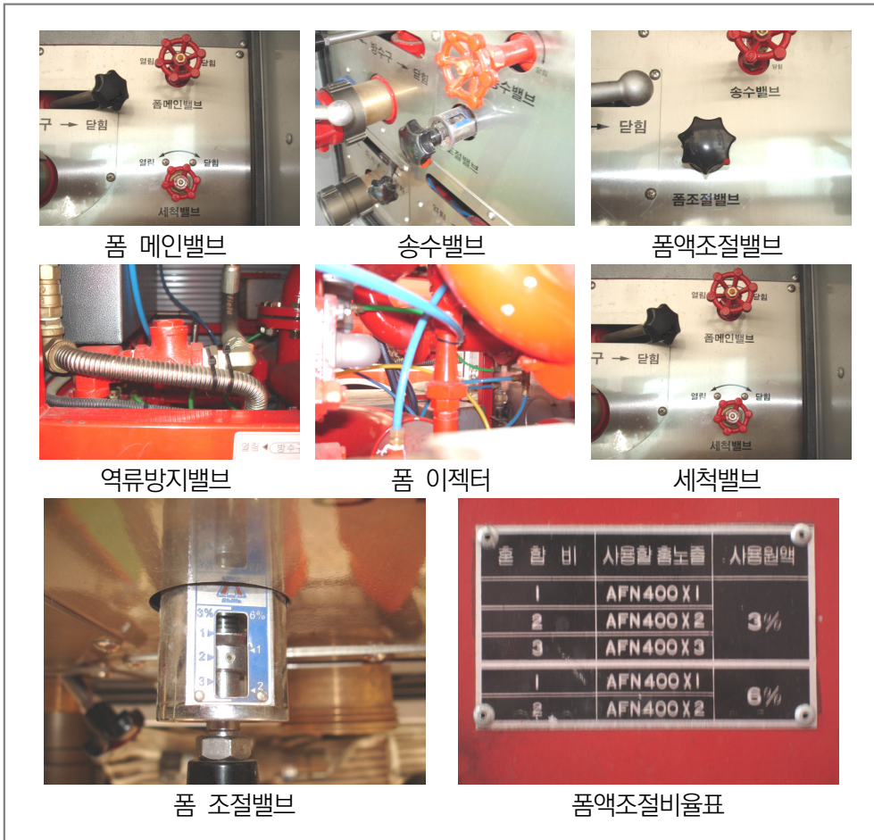
[그림 3-71] 펌프프로포셔널방식 구성품 및 배율조절
