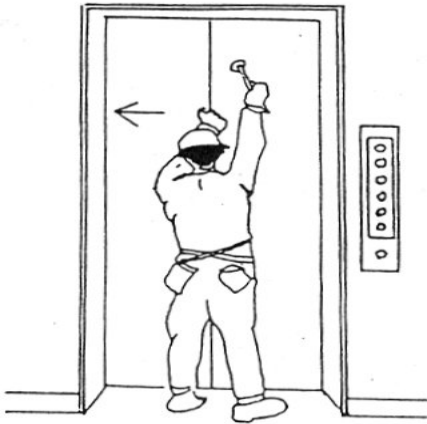
마스터키를 이용한 1차 문 개방(좌)
